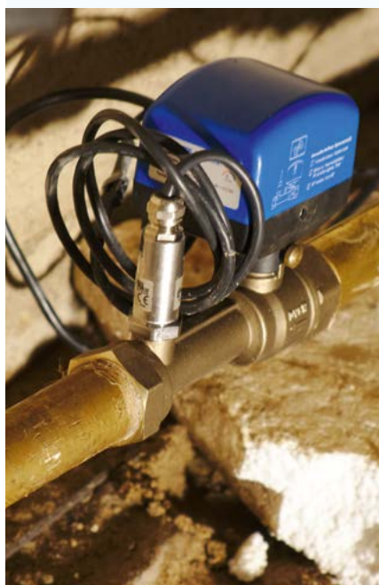
Bild 2 / Installationsbeispiel eines Leckageschutzsystems „Wasserleck Protect“, OV-Tech. Links: Absperrventil in der Hauptwasserleitung, rechts: Bewegungsmelder über einem Waschbecken
