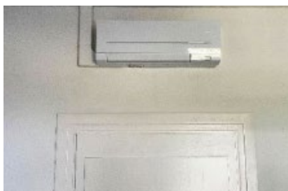
Abb. 41: Inneneinheit des Splitgeräts
