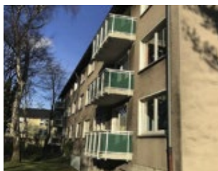
Abb. 48: Gebäude vor Sanierung
