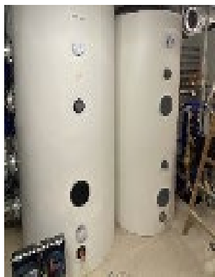
Abb. 45: Zentrale Trinkwasser-speicher
