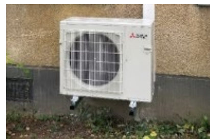
Abb. 43: Einzelnes Außengerät
