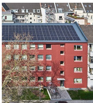
Abb. 66: Gebäude nach der Sanierung
