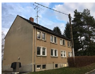
Abb. 39: Gebäude vor Sanierung mit Wärmepumpen-Außenluft-Einheit
