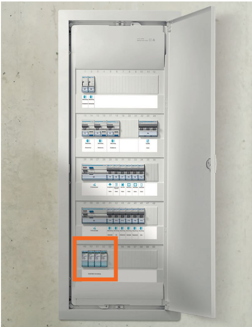
SPD Typ 2 in einer Unterverteilung
