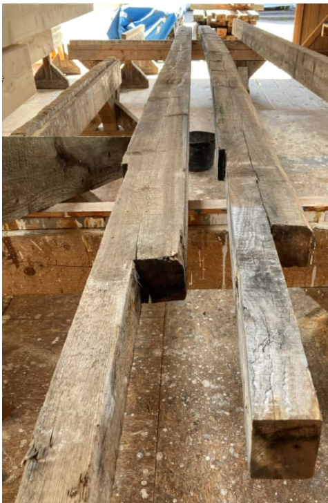
Aufbereitung der gesicherten Hölzer für die Wände
