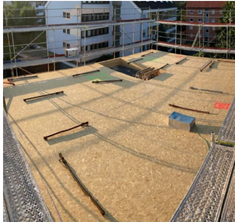
Fertige OSB-Plattenlage auf der Holzbalkendecke
