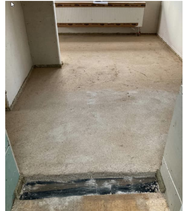
Fertiger Steinholzestrich mit der darunter befindlichen Korklage
