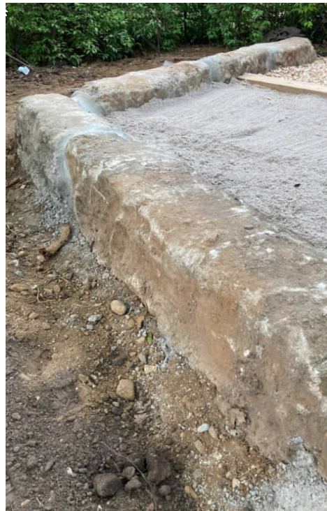
Sandkasten-Einfassung aus Fundamentresten
