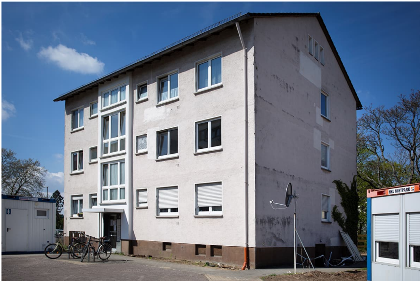
Dreieichstrasse 5, Kelsterbach | Zustand vor der Umsetzung
