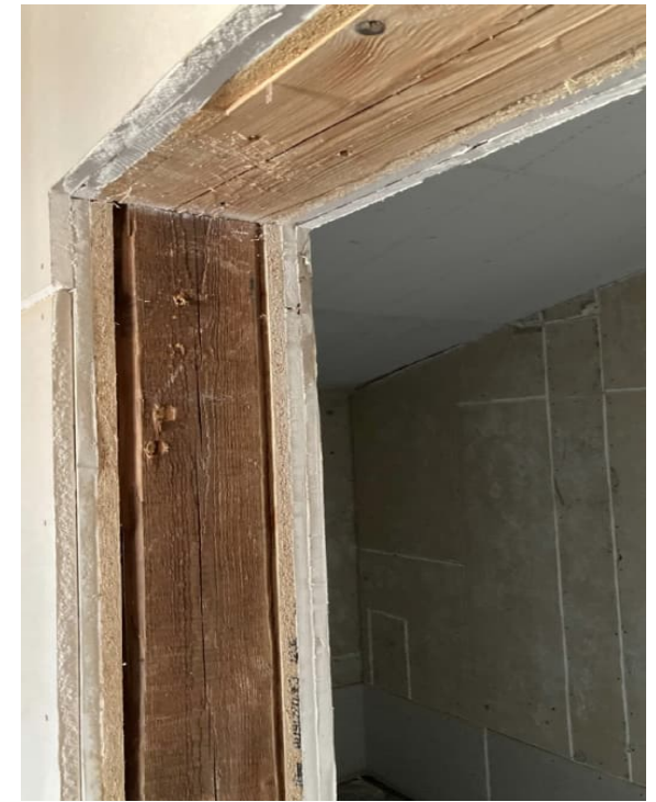
Detailbild der Türöffnung einer Innenwand (beidseitig GK-Platten)
