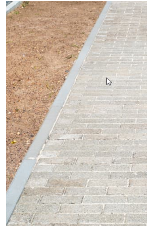
Wiederverwendete Pflasterbeläge vom CUBITY, FFM
