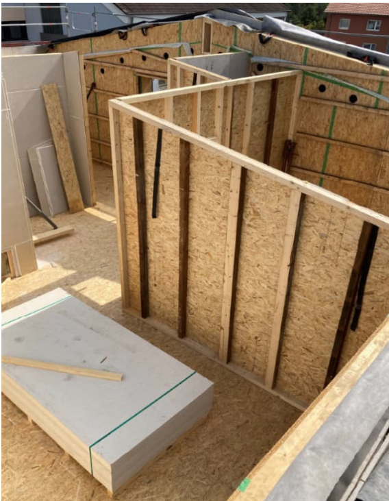
Stellen der Holzrahmenbauwände – Innenwand 100% recyceltes Holz
