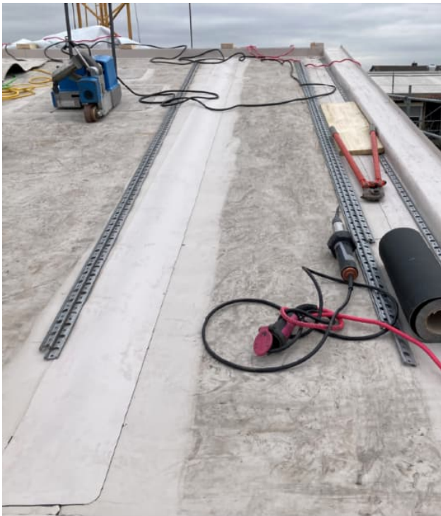
Kombination der recycelten Dachbahn mit den neuen Anschlüssen
