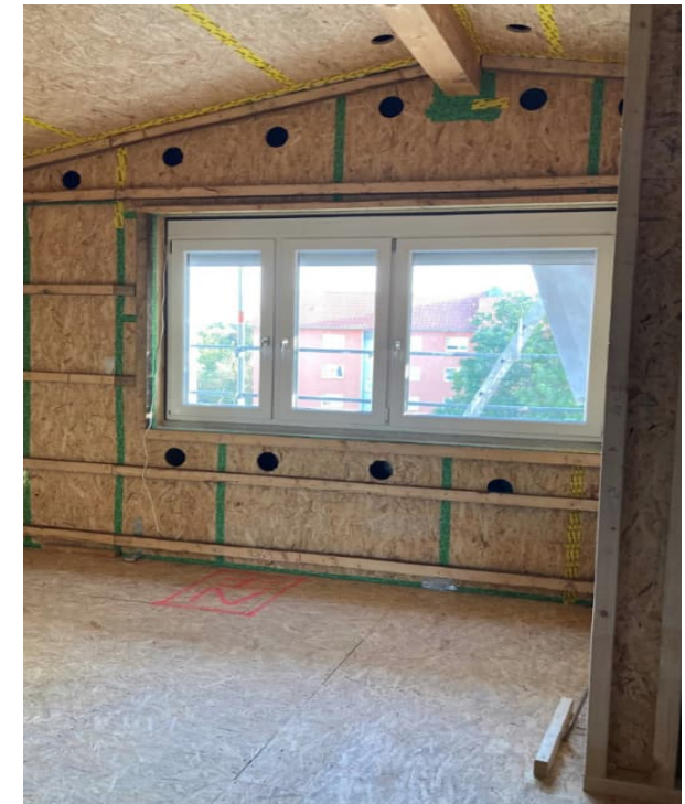
Eingebaute Fenster aus der Comeniusstrasse, WI mit neue Iso-Glas-Scheiben mit einem höheren g-Wert. (ARGON-Füllung)
