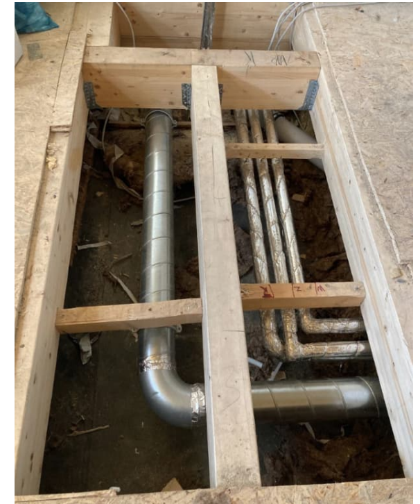
Wechsel in der Sparrenlage Zwischendecke mit Installationen
