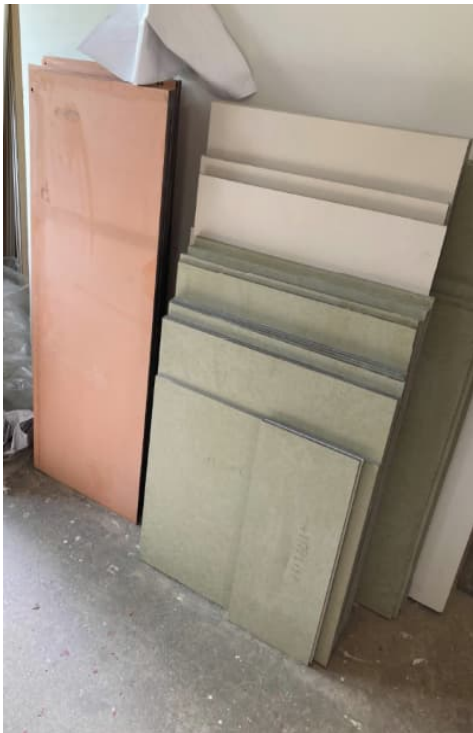
Geschliffene & Zugeschnittene Fassadenplatten
