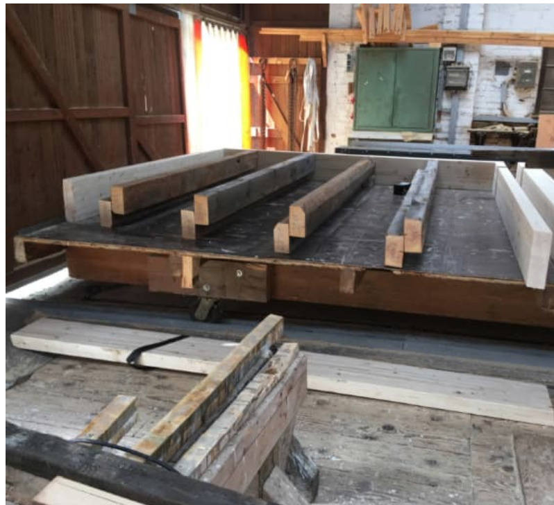
Einbau der recycelten Hölzer in die Wände. DOPPELSTÄNDER wegen des Wandquerschnitts!
