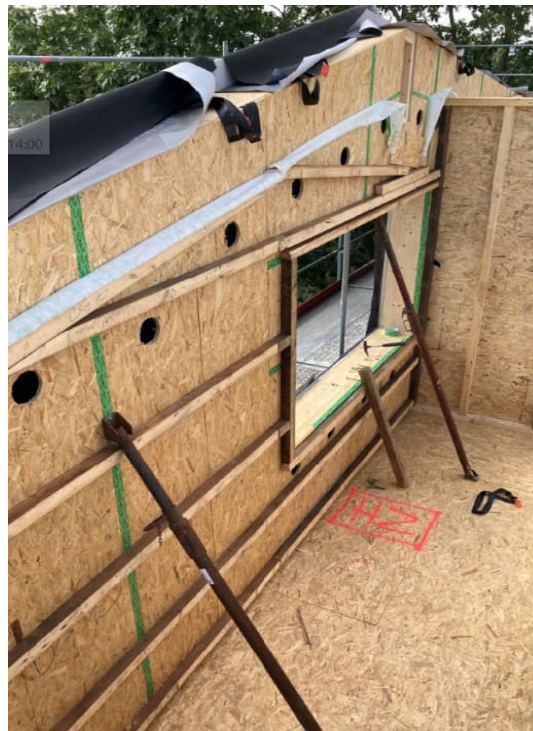
Außenwand mit runden Öffnungen für Befüllen der Wände mit Dämmstoff. Einblasdämmung 100% Zellulose
