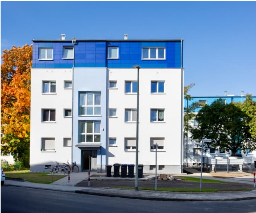
Außenansicht nach Fertigstellung – Strassenseite Dreieichstrasse 5
