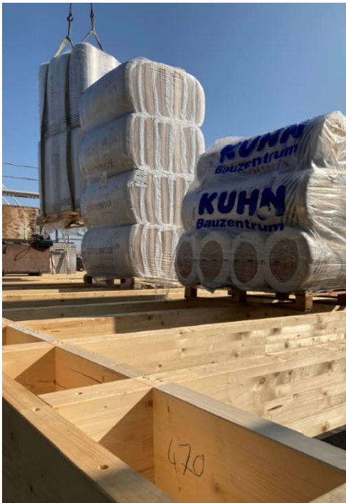
Ausdämmen der Installations-/Balkenlage mit Mineralwolle
