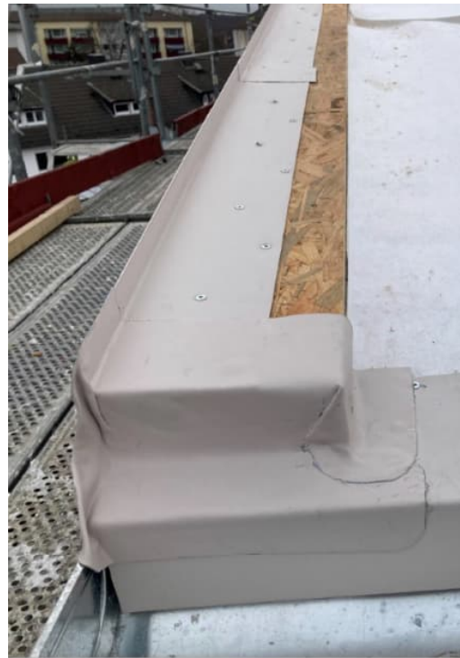
Anschlussbereiche Ortgang – aus neuer Dachbahn
