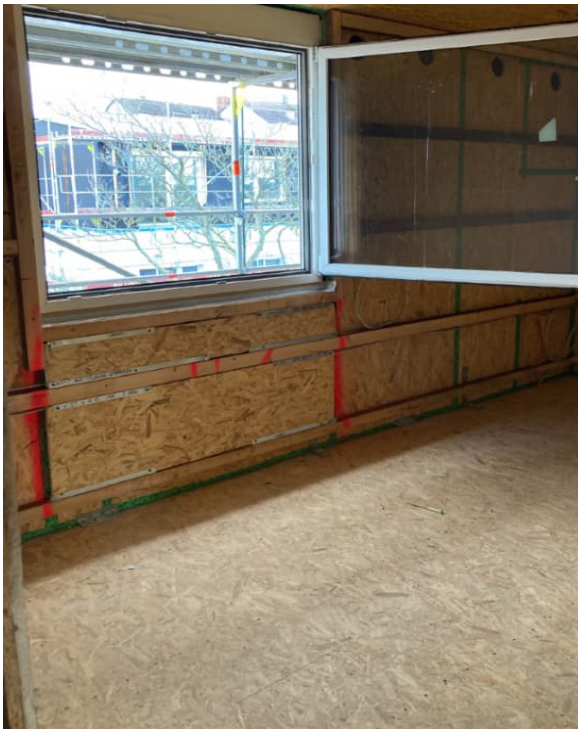
OSB-Plattenlage vor dem Einbringen der Korkschüttung
