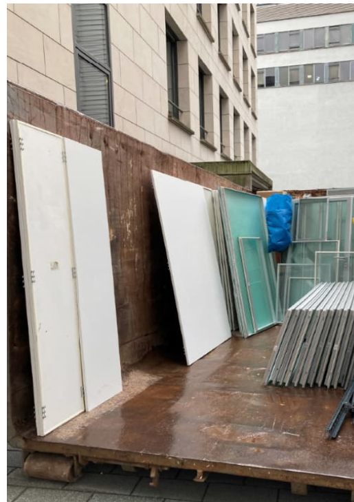
Gesicherte Einbauelemente bei Büroumbauten der NHW, FFM wurden als Innenfensterbänke wieder eingesetzt
