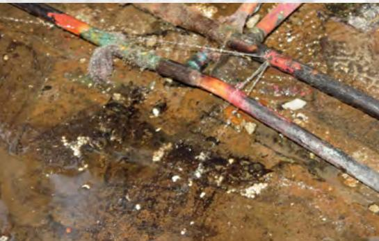
**Bild 3** | Nach dem Öffnen des Fußbodens liegen die Leckagestellen frei.
