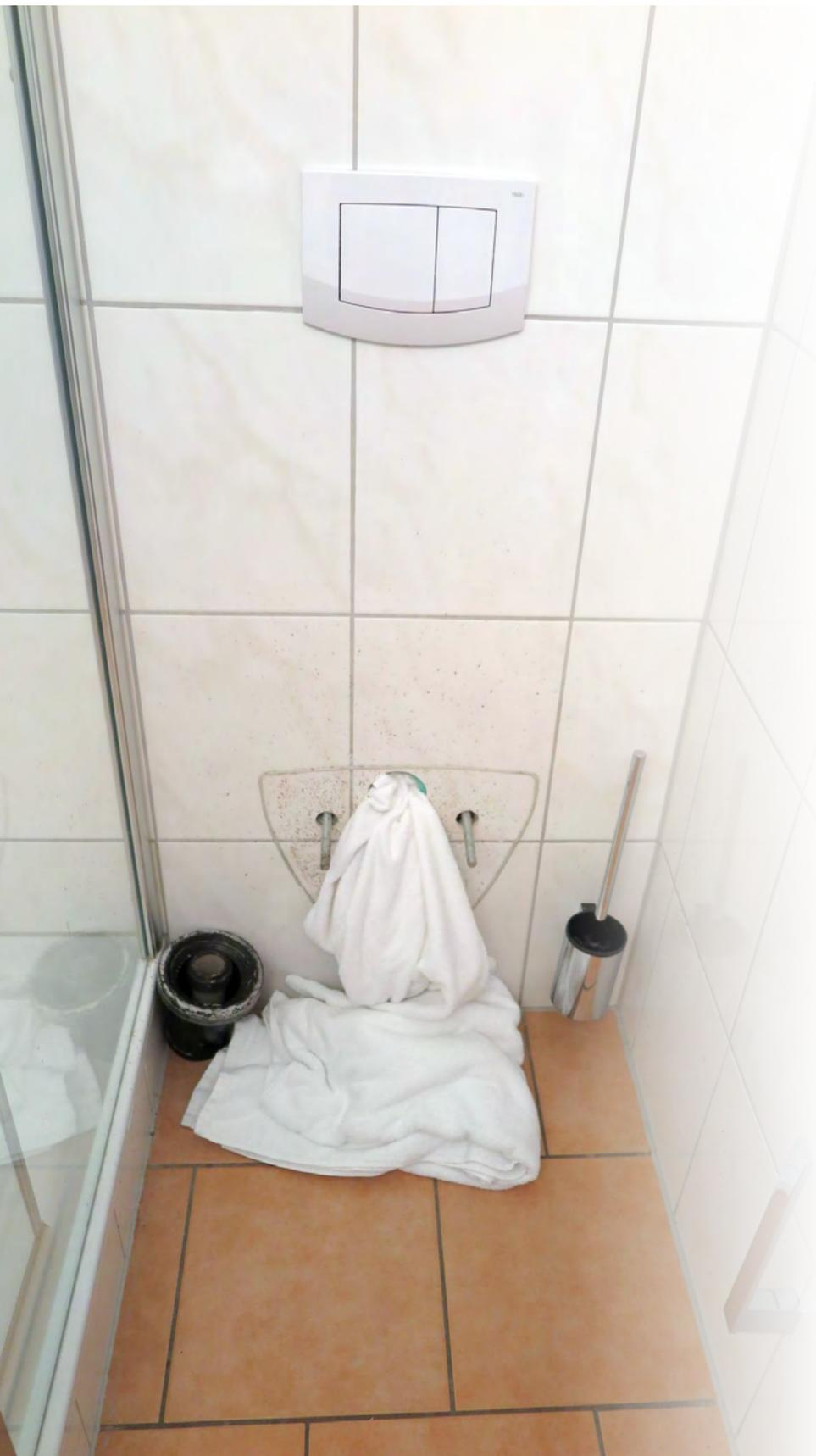
**Bild 9** | Durch die Leckage am WC-Anschluss drang Fäkalwasser in die Wand und in den Fußbodenaufbau.
