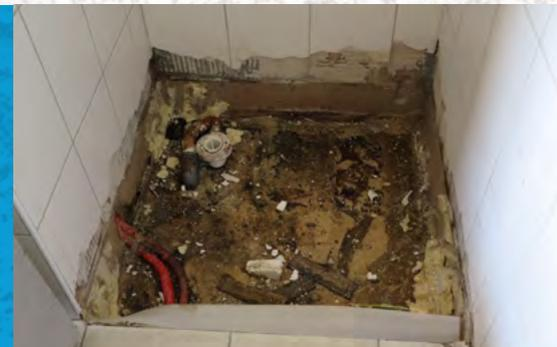
**Bild 5** | Das Duschwasser hatte sich unter der Duschwanne gesammelt und von dort den Fußboden im Erdgeschoss durchfeuchtet.
