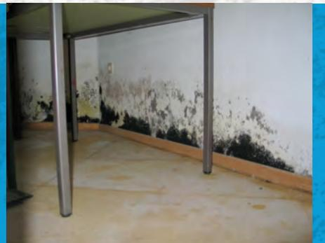
**Bild 4** | Aufsteigende Feuchtigkeit führte zu einem massiven Schimmelbefall.
