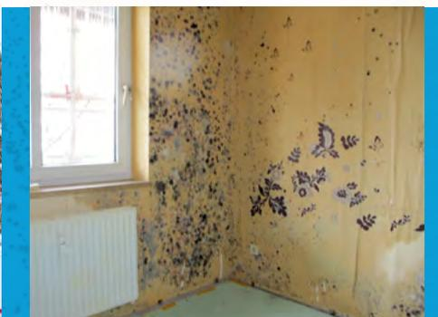
**Bild 7** | Auch im Erdgeschoss führte das Löschwasser zum Schimmelbefall.
