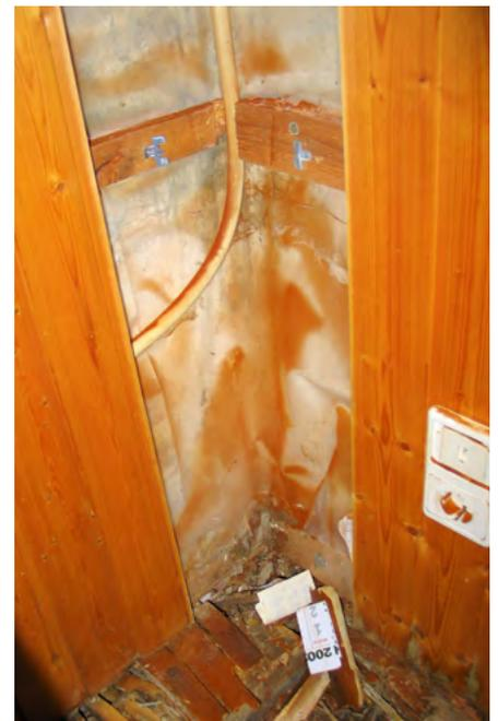
**Bild 10** | Befall durch den Echten Hausschwamm. Durch den gut gemeinten Trocknungsversuch wurden die roten Sporen erst richtig verteilt.
