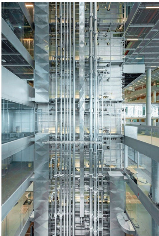
Im Bürogebäude des Axel-Springer-Neubaus (2020) ist ein aktuelles, prägnantes Beispiel für die offene, transparente Verlegung für alle Ver- und Entsorgungsleitungen in einem Lichthof demonstriert. Foto: Geberit
