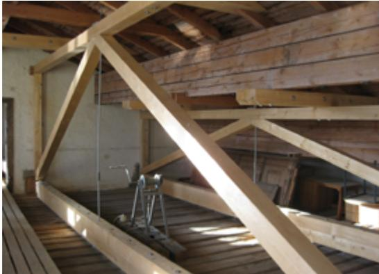
und Sitzungssäle des Landgerichts und durften durch die Sanierungsmaßnahme unter keinen Umständen gefährdet werden. Getragen wird die Mann-an-Mann-Decke durch ein historisches Sprengwerk aus dem Jahr 1680, zusätzlich hängt sie an einer Metallverstärkung, die vor etwa 15 Jahren zur statischen Ertüchtigung eingefügt wurde. Ende 2009 wurde die Mann-an-Mann-Decke im Zuge der Sanierungsmaßnahmen mit
