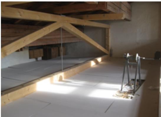
Durch ihre hohe Flexibilität lassen sich holzFlex® protect Dämmmatten gut verarbeiten und passen sich den örtlichen Gegebenheiten optimal an. In kürzester Zeit verlegten die Handwerker der Krenn Holzbau GmbH auf der obersten Geschossdecke im Landgericht Passau 800 m<sup>2</sup> Dämmmatten und dämmten die Decke somit auf einen nahezu passivhaustauglichen U-Wert von 0,141 W/(mK). Auf den zu Revisionszwecken auch
