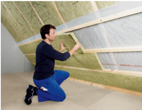
Energieeffizient geplante und ausgeführte Gebäude besitzen nicht nur eine sehr gute Wärmedämmung aller Außenbauteile, sondern auch eine entsprechend angepasste Luftdichtheit der Gebäudehülle. Damit soll ein unnötiger Wärmeverlust durch Fugen und Anschlussbereiche vermieden werden. Allerdings muss in Abhängigkeit von seiner Nutzung jedes Gebäude auch ausreichend gelüftet werden können. Die bei Altgebäuden häufig vorhandene
