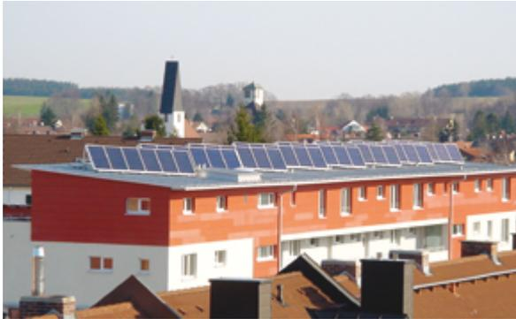
Sowohl nicht belüftete Dächer (Warmdach) wie auch belüftete Dächer (Kaldach) können mit multifunktionalen Dacheindeckungen ausgeführt werden. Prädestinierte Dachformen sind Tonnen-, Pult-, Sattel-, Walm- und Schmetterlingsdächer. Ihre Dachflächen sollten südlich ausgerichtet und zwischen 20 und 60 Grad geneigt sein. Aufgeständerte Anlagen
