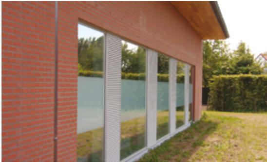
mit einem aussenliegenden Sonnenschutz kann diese Überhitzung vermieden werden. Durch eine intelligente Kombination von Lüftung und Sonnenschutz hat RENSON® mit dem Healthy Domestic Concept® eine Gesamtlösung für Wohnungen entwickelt. Dieses System garantiert ein gesundes Innenklima sowie eine abgestimmte Temperatur und reduziert den
