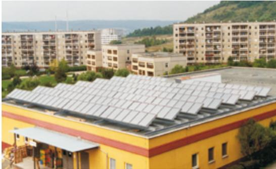
Solarmodul rückseitige – also auf der Wind abgekehrten Seite – mit einer Verkleidung aus, um die Luftanströmung zu lenken. In den meisten Fällen werden Stahlkonstruktionen verwendet, in die Solarmodule befestigt werden. Diese Konstruktionen müssen eine auftretende Windlast sicher in die Dachkonstruktion ableiten. Das kann über feste Verankerungen
