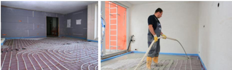
Das Energiekonzept setzt auf Fußbodenheizung.
