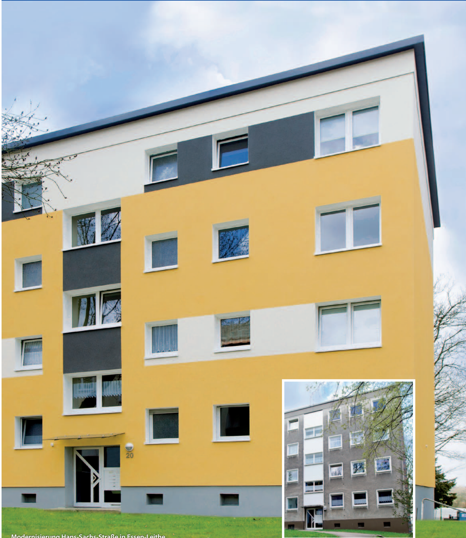
Modernisierung Hans-Sachs-Straße in Essen-Leithe.
